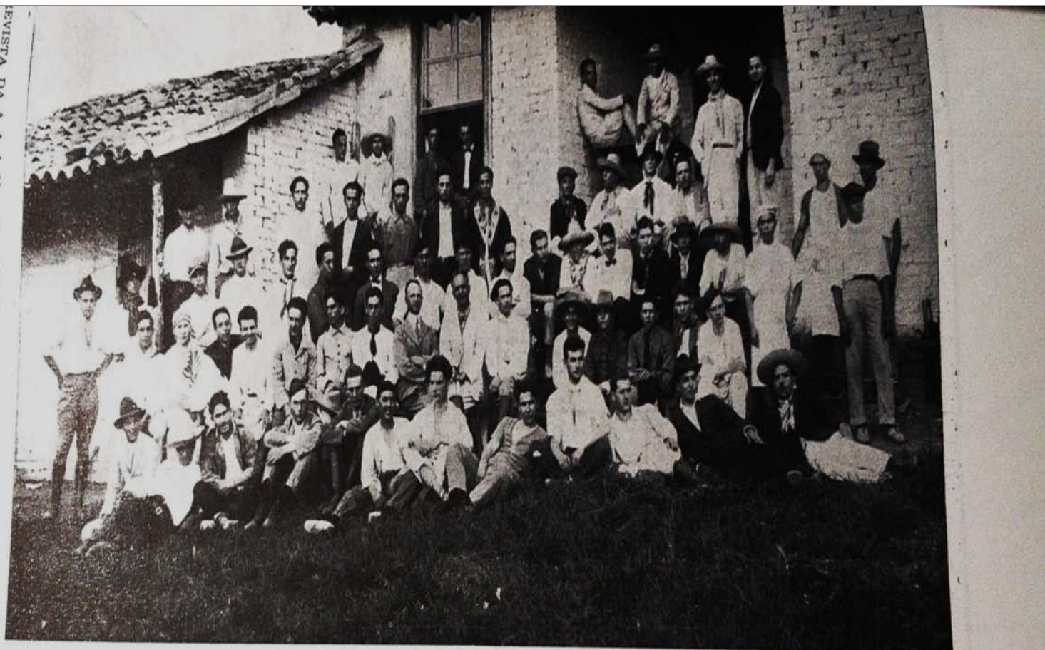
Acampamento de 1923 em Barueri (km. 32 da Estrada de Ferro Sorocabana)
